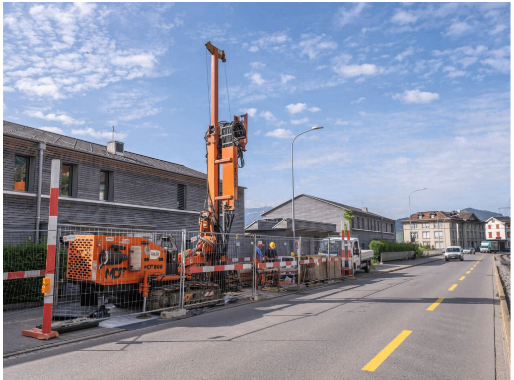
Seit Anfang Juni sind die Bohrgeräte der Paler Spezialtiefbau AG bei der Hauptstrasse im Einsatz. Nerina Keller
