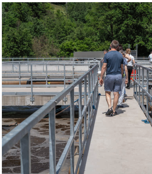
In den Biologiebecken gibt es teilweise Belüftung.
