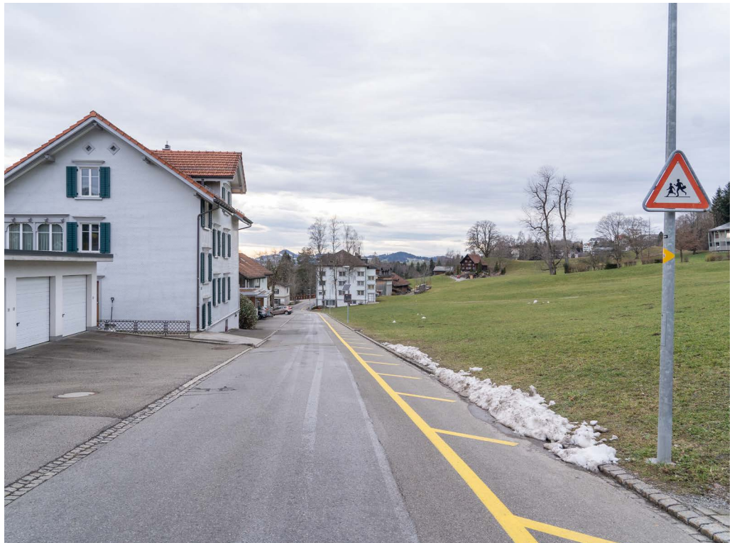
Auch auf der Baustellen-Liste: Die Friedhofstrasse soll heuer ein Trottoir bekommen. Foto: nek
