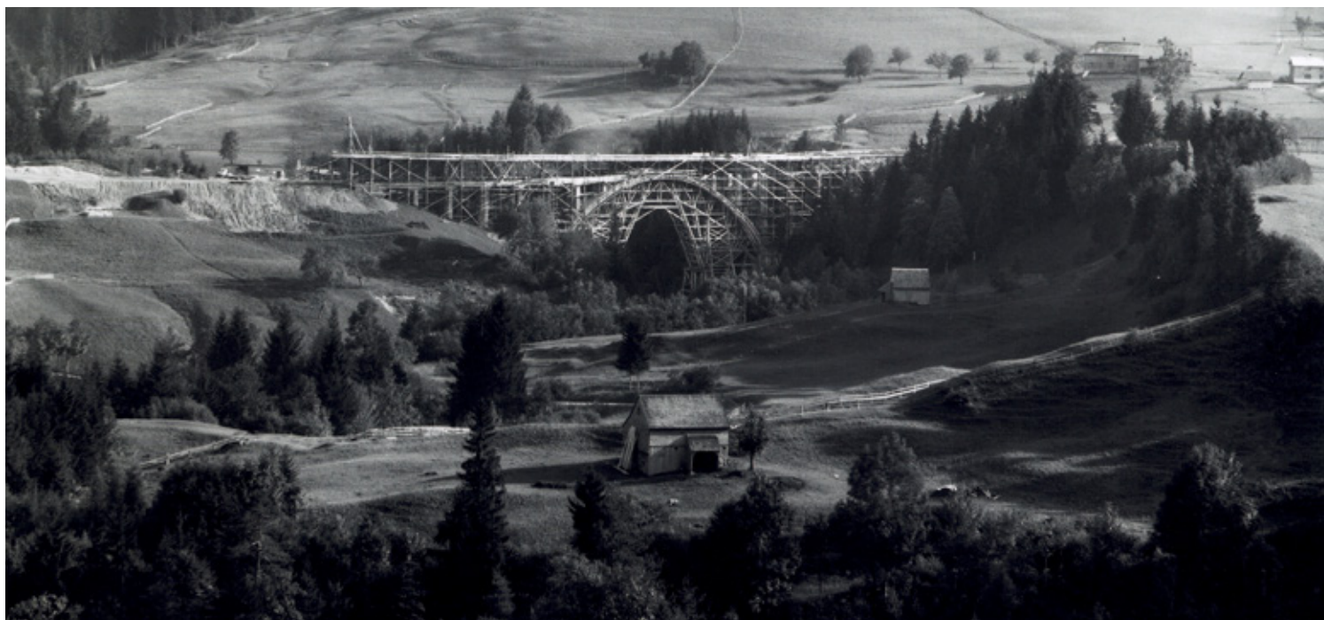
Lehrgerüst und darüberliegende Hilfsbrücke aus der Distanz, Sommer 1924. Fotos: Ortsgeschichtliche Sammlung Teufen
