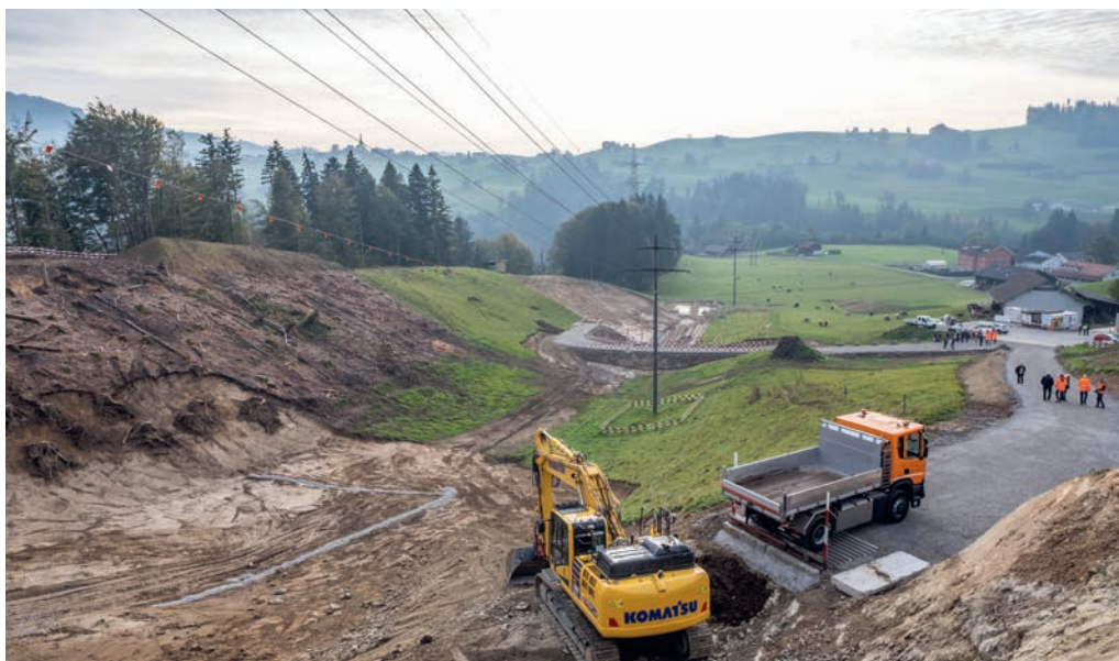
Die erste Ladung ist deponiert: Hier oben wird das saubere Aushubmaterial «Typ A» eingebaut. In den nächsten Jahren wird sich die ganze Geländekammer nach und nach füllen. Fotos: tiz
