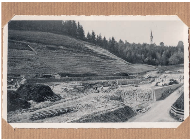
Diese Aufnahmen wurden während der intensiven Bauarbeiten gemacht. Der Aushub erfolgte von Hand – rund 40 Männer waren daran beteiligt.
