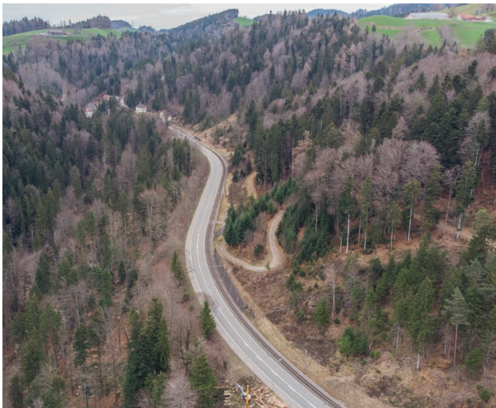
Als erster Schritt soll der bestehende hangseitige Rad- und Gehweg deutlich verbreitert werden. Fotos: tiz
