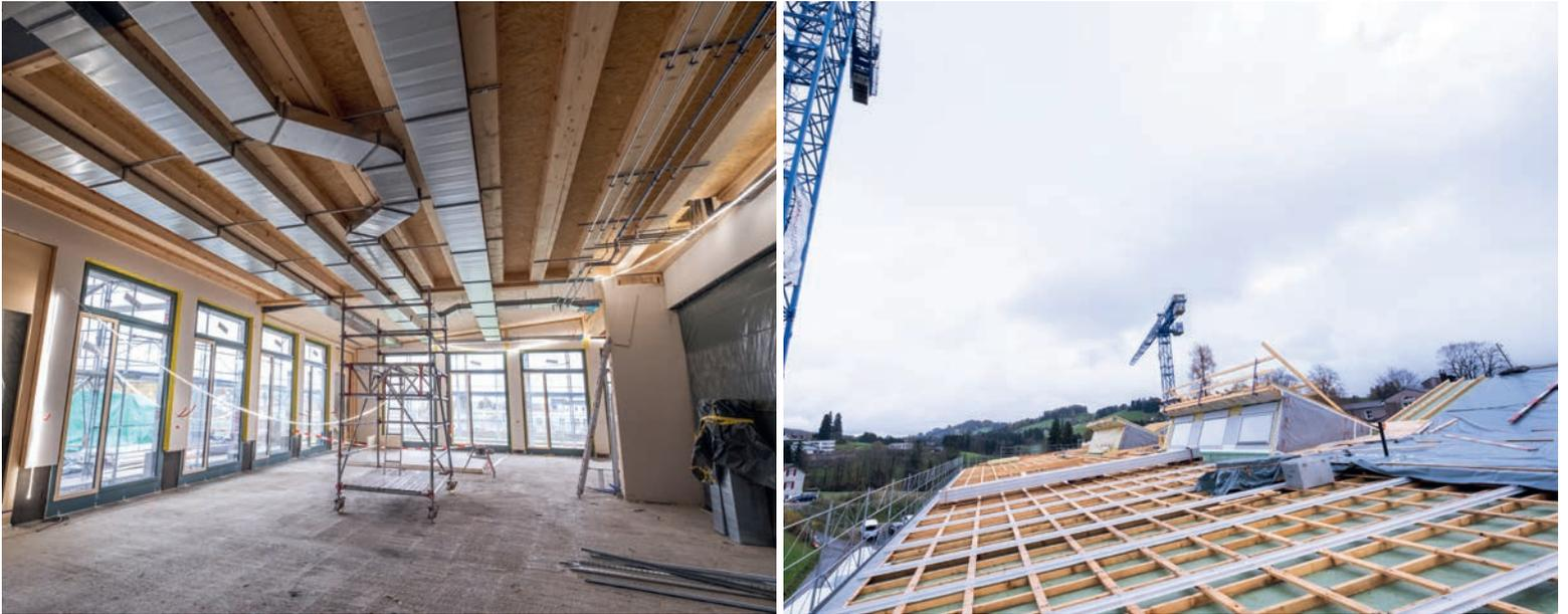
Die neue Sekundarschule ist noch immer eine Grossbaustelle: Aber die Holzelemente sind schon fast vollständig aufgerichtet – und die PV-Anlage wird erwartet. Fotos: tiz
