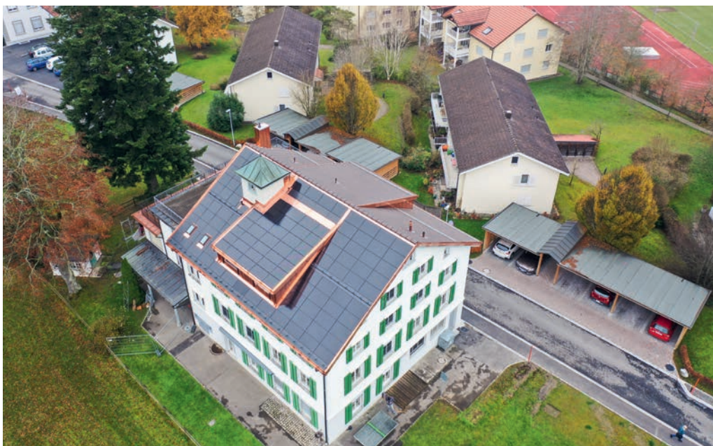
Die Solaranlage auf dem Dach der Gruppenunterkunft Alpstein. Sie wurde im Zuge der Dachsanierung im vergangenen Jahr installiert. Foto: Damian Imhof / kurzschluss photography
