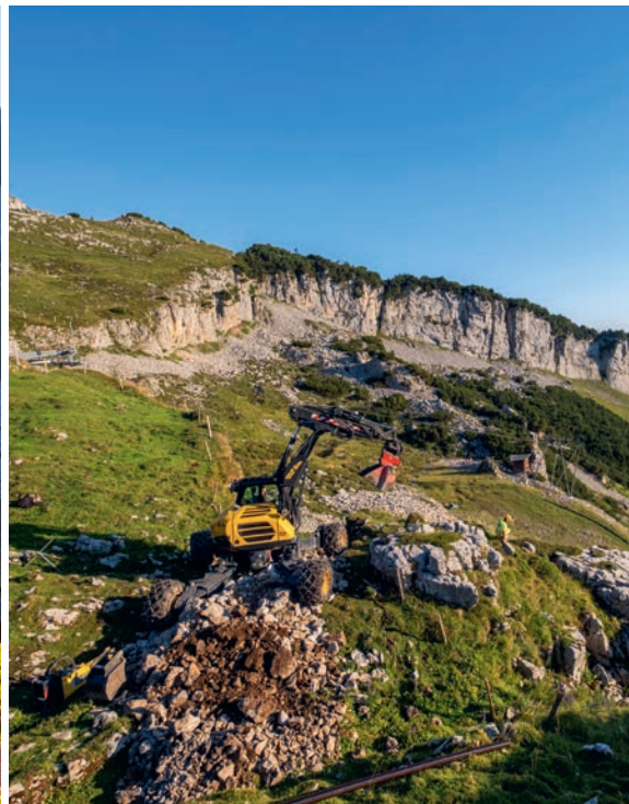
Der felsige Aushub wird fürs Auffüllen ausgesiebt.
