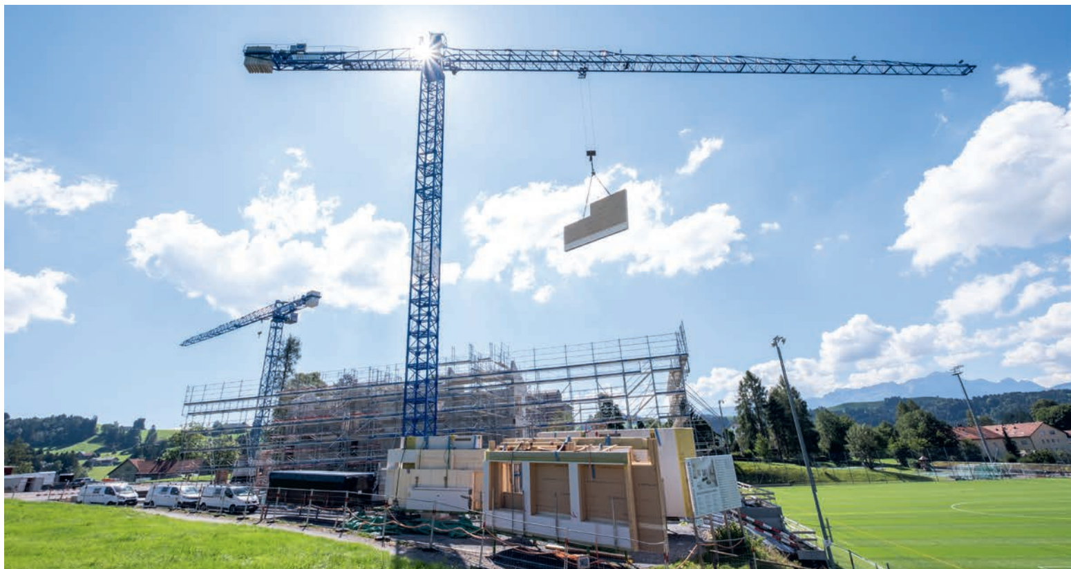
Die neue Sekundarschule besteht aus 545 Holzelementen. Ende August begann die erste von vier Aufrichte-Etappen. Foto: tiz
