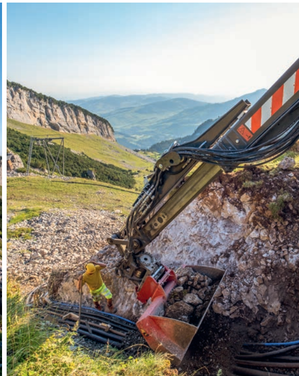
Die Leitungen werden bis zum «Schäfler» gezogen.
