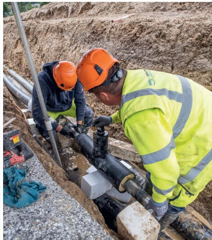
Hier wird gerade ein Entlüftungsventil installiert.
