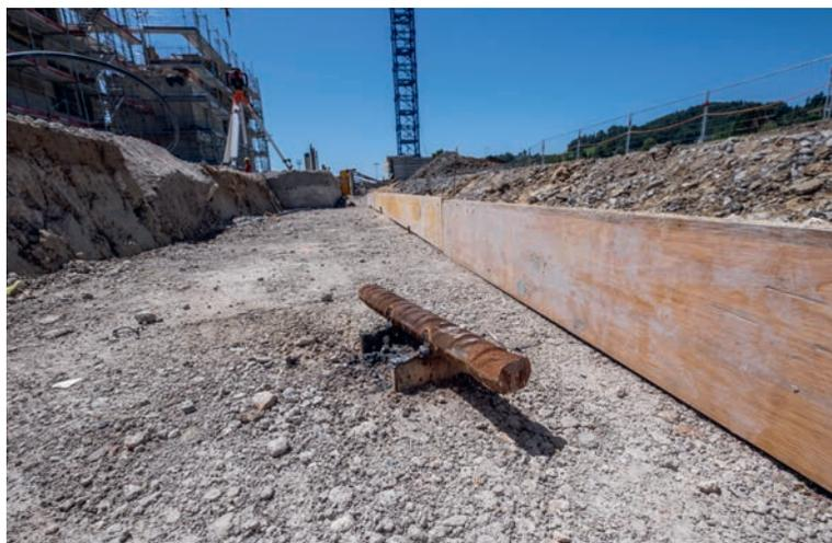
Vor dem Betonieren wurde hier einst eine beachtliche Grube ausgehoben: 4600 Kubikmeter Material. Darauf folgten 180 Pfähle mit einer Gesamtlänge von 1,1 Kilometern. Sie wurden in den Felsen im Untergrund gerammt und sorgen für die nötige Stabilität des Gebäudes. Jetzt ist von ihnen nicht mehr viel zu sehen – ausser diesen kleinen Eisen. Darauf kommen nun Wände und Bodenplatte bzw. deren Armierung zu liegen.
