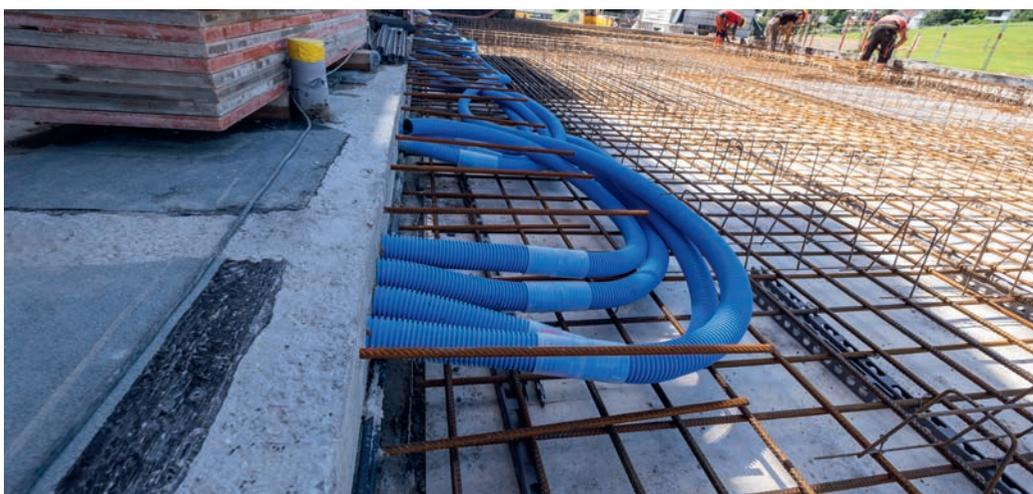
Diese blauen Schläuche werden in der Bodenplatte «inbetoniert». Sie sind die grösseren Brüder der kleineren Röhren in der Wand des Treppenhauses (Foto 1). In diese Röhren werden später die Stromkabel eingezogen. Der grosse Vorteil beim Sekundarschulhaus: Lüftung und viel Technik können in den Holzdecken untergebracht werden. «So haben wir kein Platzproblem in den Betondecken und -Wänden.»
