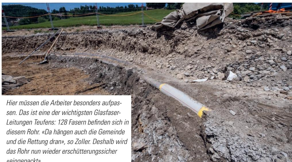
Hier müssen die Arbeiter besonders aufpassen. Das ist eine der wichtigsten Glasfaser-Leitungen Teufens: 128 Fasern befinden sich in diesem Rohr. «Da hängen auch die Gemeinde und die Rettung dran», so Zoller. Deshalb wird das Rohr nun wieder erschütterungssicher «eingepackt».
