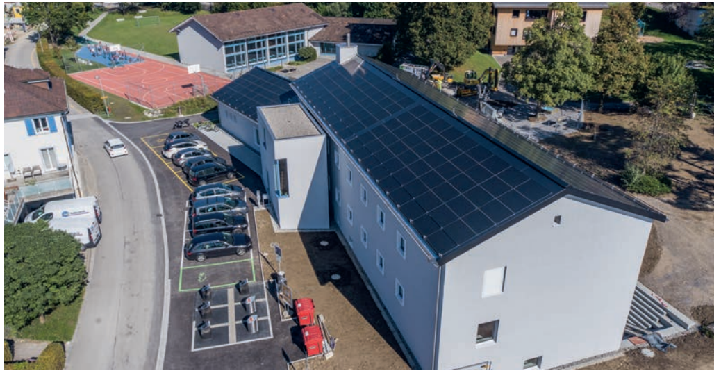
Die Photovoltaik-Anlage auf dem gesanisierten Schulhaus Blau ist die grösste der Gemeinde. Foto: Archiv
