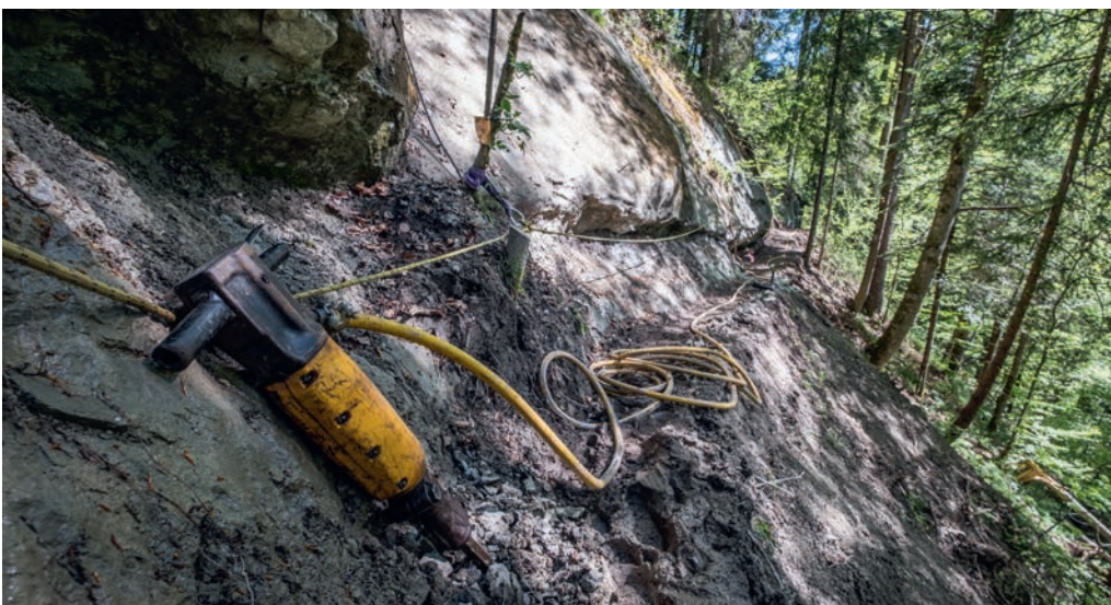
Oben: Beim neuen Weg zum Höchfall wird ein innovatives Wegbaukonzept mit Treppenelementen eingesetzt. Unten: Teilweise schmiegt sich der Weg am Sandsteil-Fels entlang. Hier muss einiges abgespitzt werden.
