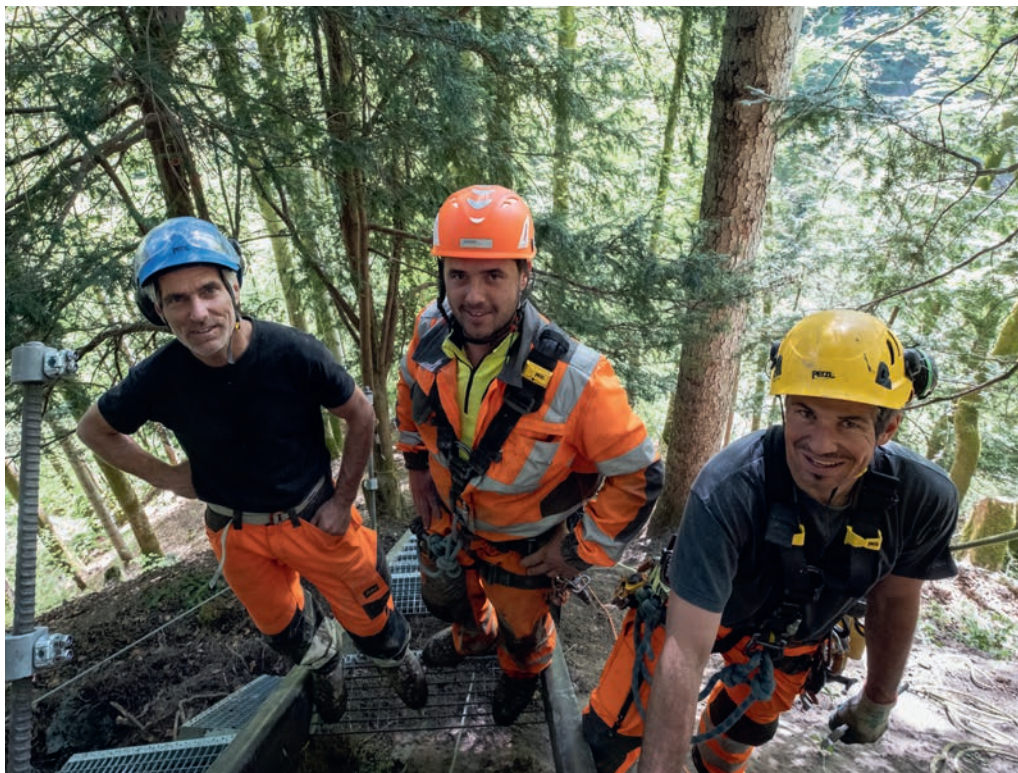
Bauleiter Oliver Zangerl (Mitte) mit Sicherheitsberater Andreas Brunner (links) und einem Höhenarbeiter. Foto: tiz
