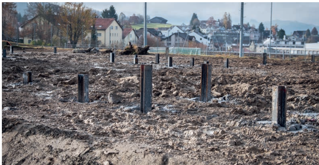
Die 180 Pfähle sorgen für die nötige Stabilität. Bei einigen musste ein zweiter «nachgereicht» werden, weil man auf Felsen stiess.
