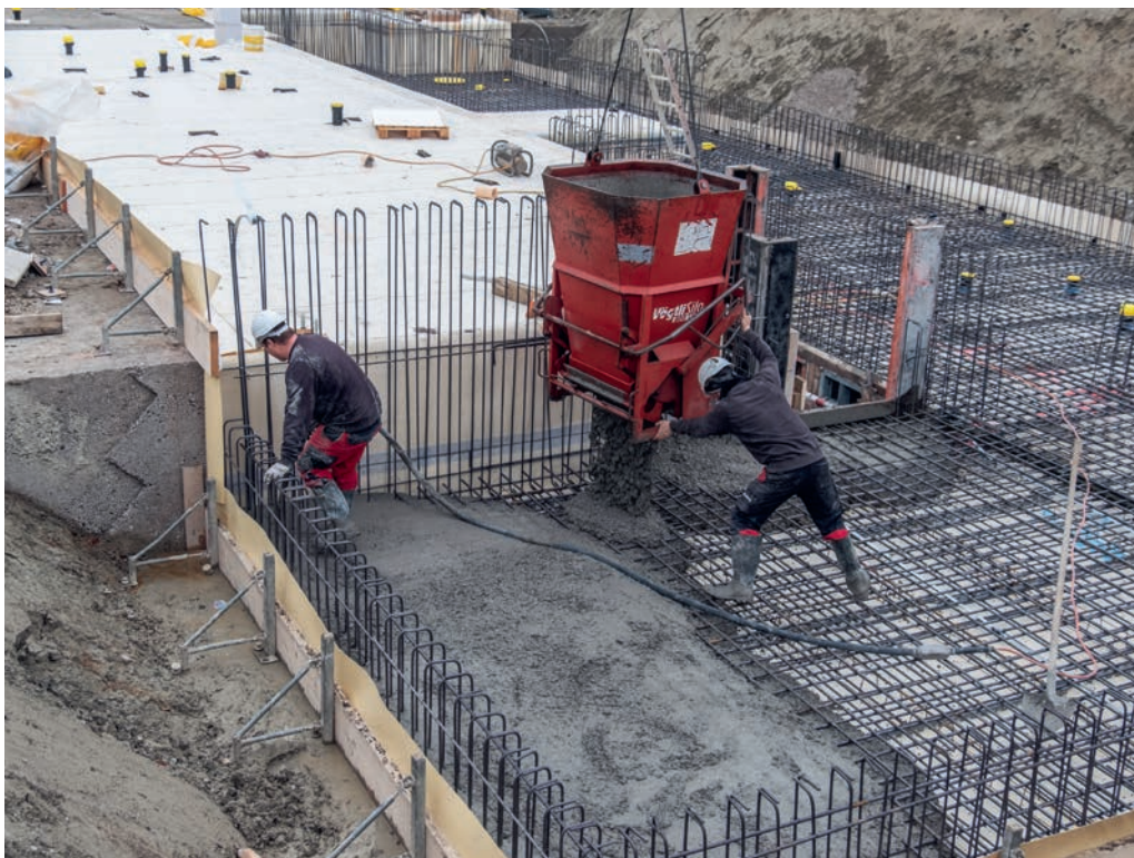
Ende November wurde die erste Bodenplatte im Untergeschoss betoniert. Fotos: tiz
