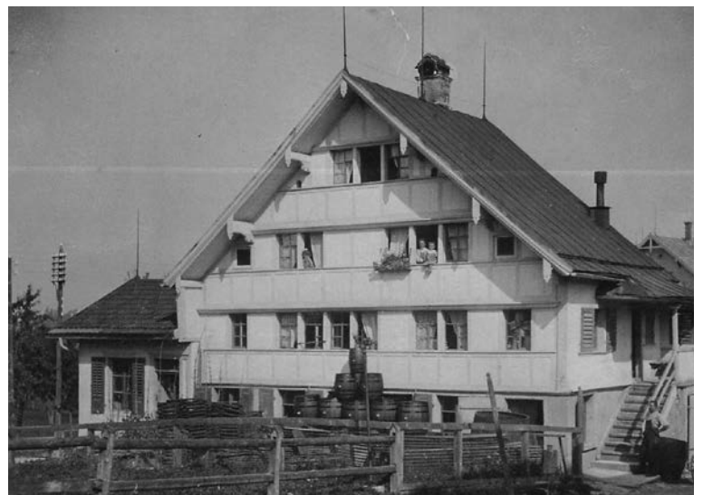
Küferei Kappeler an der Zeughausstrasse, 1930. Das Gebäude wurde im Jahr 2005 abgebrochen.
