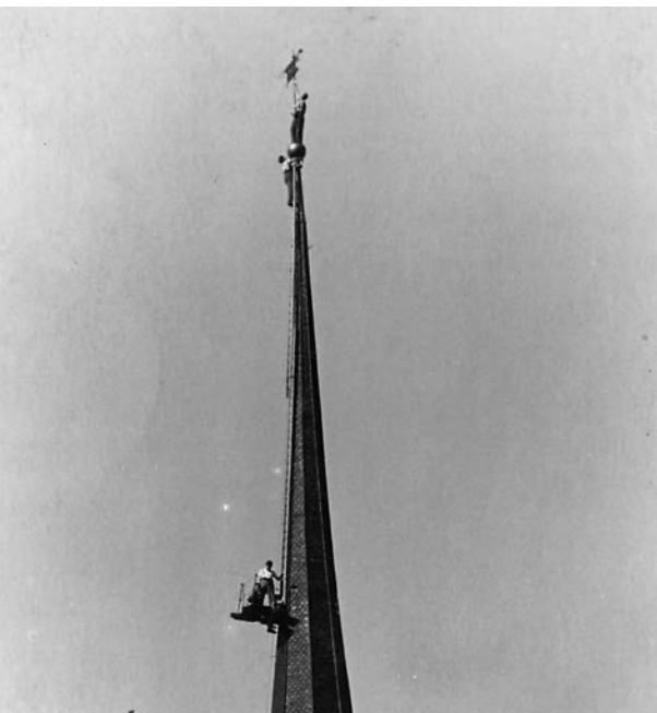
«Vati in der Höhe». Reparaturarbeiten am Kirchturm, Mai 1956.
