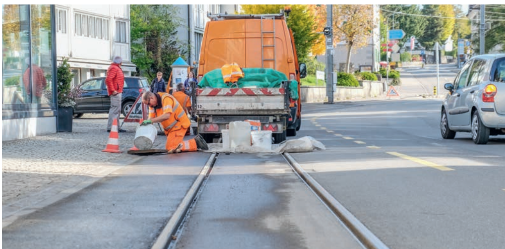
Auch das Strassenverkehrsamt des Kantons ist im Einsatz: Hier werden gerade die Schächte entlang der Bahnlinie auf Vordermann gebracht. Foto: tiz
