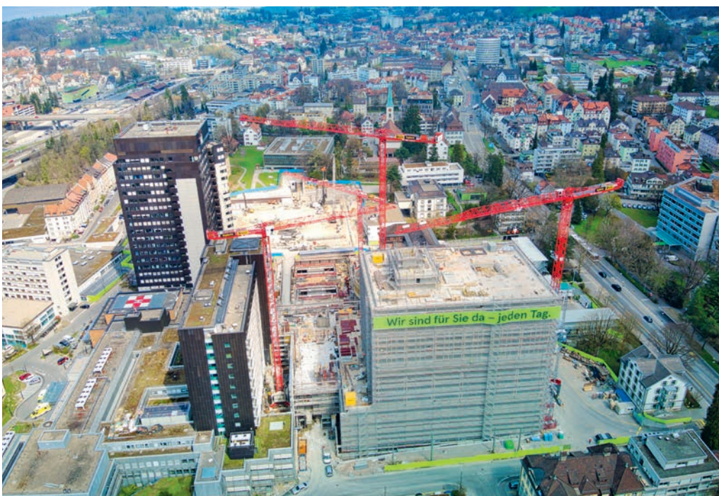
Trotz Baustelle rund um die Uhr offen: Beim Kantonsspital St.Gallen (KSSG) arbeiten rund 2200 Pflegende. Die Personalsuche ist eine ständige Herausforderung. Foto: Archiv KSSG
