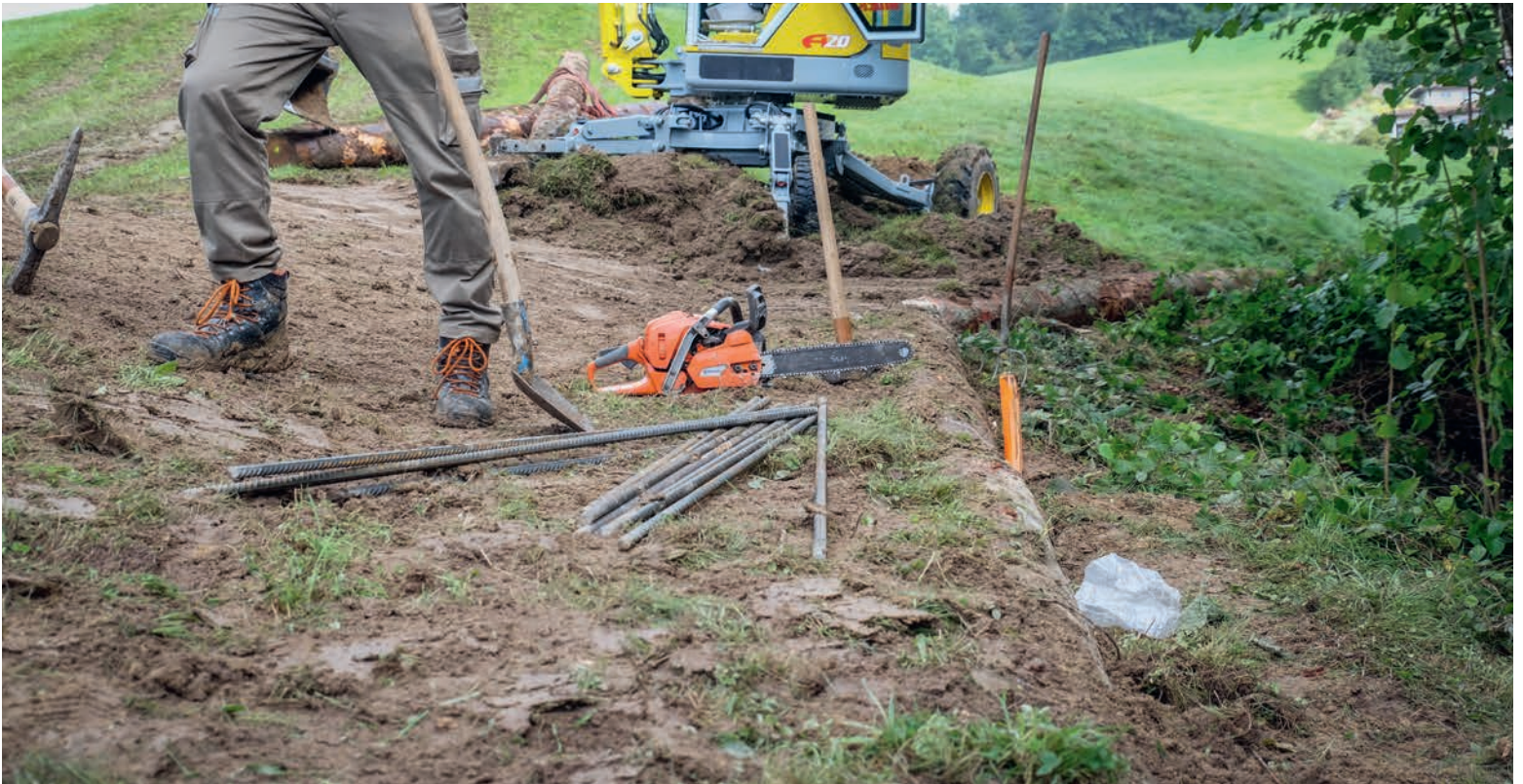
Der neue Wanderweg hinunter zum Höchfall soll im Frühjahr 2022 fertiggestellt werden. Ende August wurde mit den Arbeiten bereits begonnen. Foto: tiz
