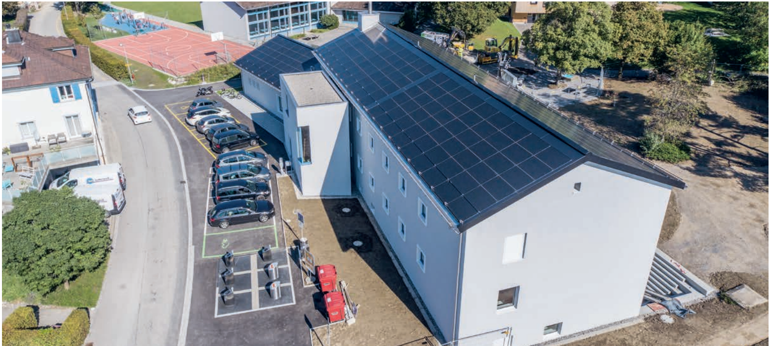
Die PV-Anlage auf dem Dach des gesamtsanierten Schulhaus Blau ist die neueste und leistungsstärkste der Gemeinde Teufen. Foto: Louis Stalder
