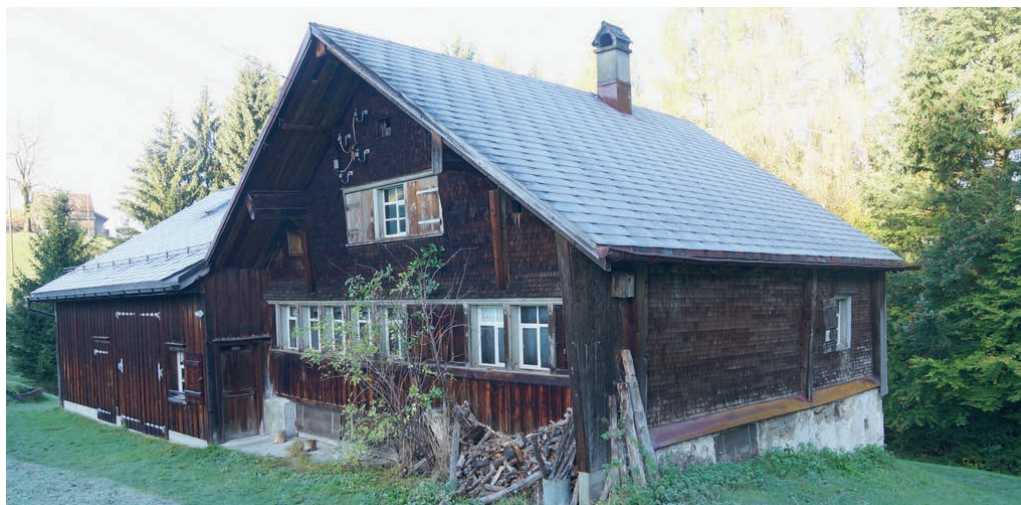
Das «Jägerhüsli» soll nun doch abgebrochen werden. Foto: Archiv
