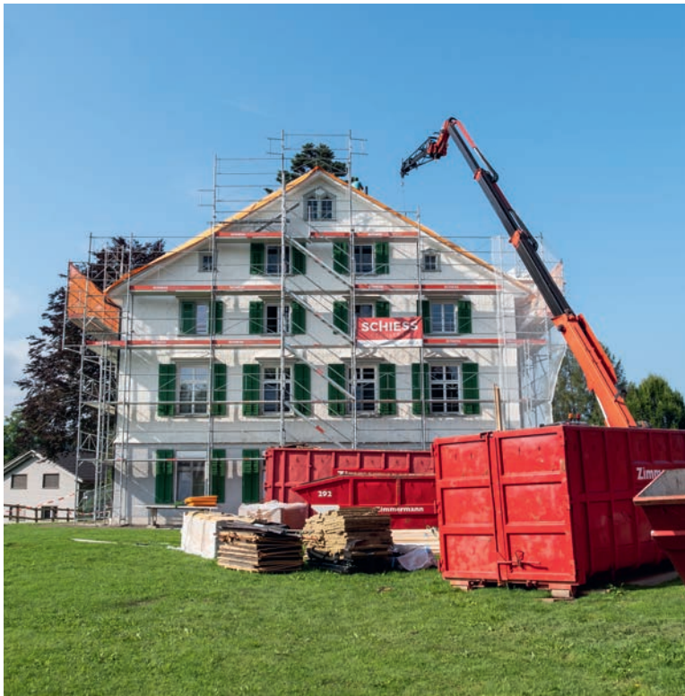
Die Gruppenunterkunft Alpstein ist seit Mitte August eingerüstet. Bis Ende Oktober wird hier das Dach saniert – inklusive PV-Anlage. Fotos: tiz
