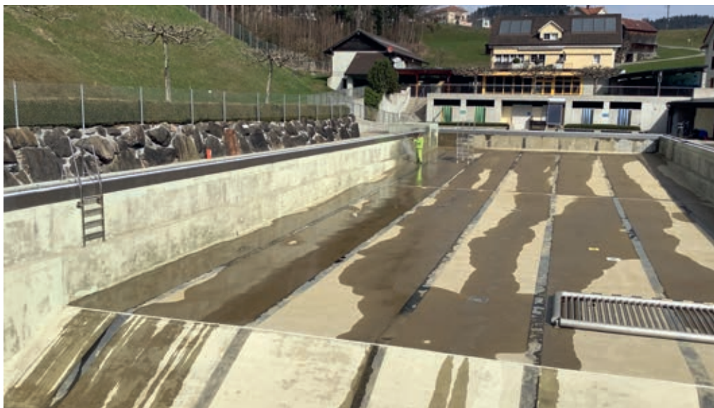
Die Putzarbeiten beim Hauptbecken sind mittlerweile abgeschlossen. Foto: zVg
