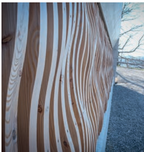
Auch ein Trinkwasserreservoir darf hübsch aussehen.
