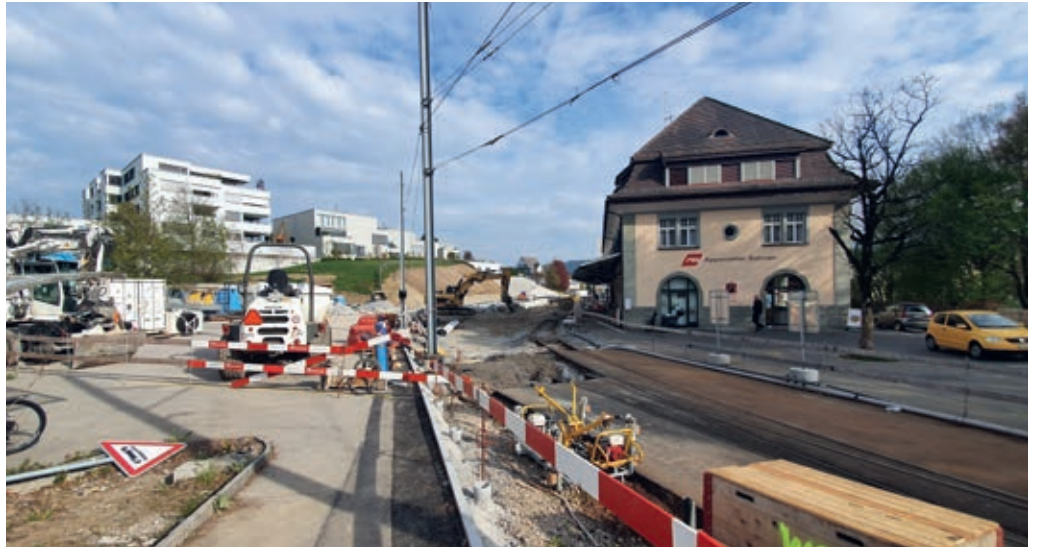
Beim Bahnhof wird zwar gebaut – mit der Doppelspur hat das aber noch nichts zu tun. Foto: tiz
