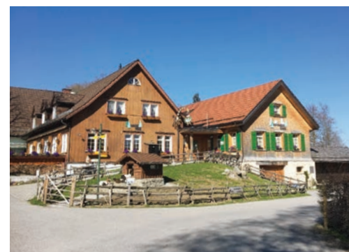
Restaurant Waldegg: Wiederaufbau Restaurant (links), Fertigstellung 1983; Anbau «Schnuggebock» (mitte), Fertigstellung 2001; Anbau «Zyträdl» (rechts); Fertigstellung 2011. Fotos: zVg.
