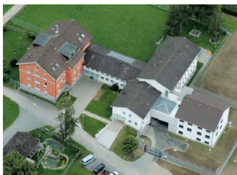
Strafanstalt Gmünden, Niederteufen: Sanierung Normalvollzug von 1994–1998; Anbau Untersuchungsgefängnis (rechts), Fertigstellung 2007.
