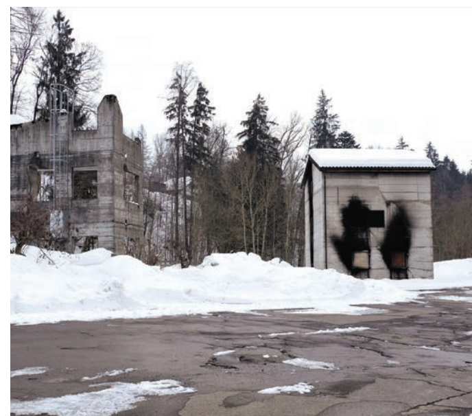
Beim Brandhaus des Ausbildungszentrums Bächli geschah der Unfall.
