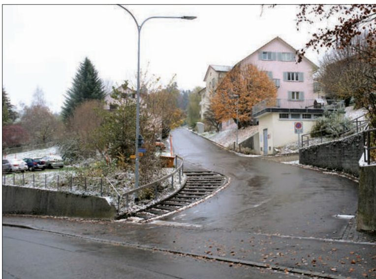
Für die Kurvenstrasse in der Lustmühle ist ein Unterflurbehälter angedacht. Grund dafür ist die enge und sehr steile Strasse.
