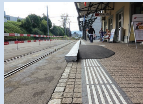
Das Provisorium im Bahnhof erleichtert den Einstieg in die neuen Tango-Züge.
