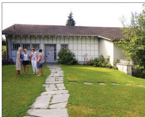
Der alte Kindergarten ist in die Jahre gekommen.
