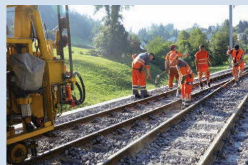
Foto links: Der Krampzug hat die Gleise millimetergenau ausgerichtet. Oben: Das Krampen – Schotterstopfen – ist auch noch Handarbeit.
