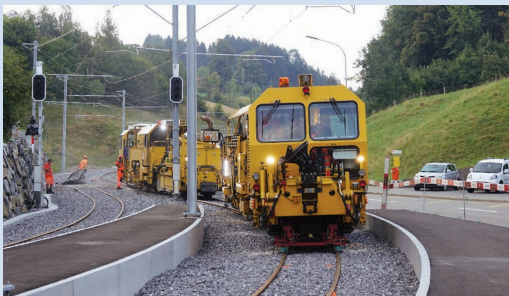
Foto links: Der Krampzug hat die Gleise millimetergenau ausgerichtet. Oben: Das Krampen – Schotterstopfen – ist auch noch Handarbeit.
