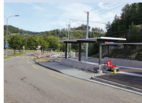
Die neue Station Lustmühle ist fast fertig.
