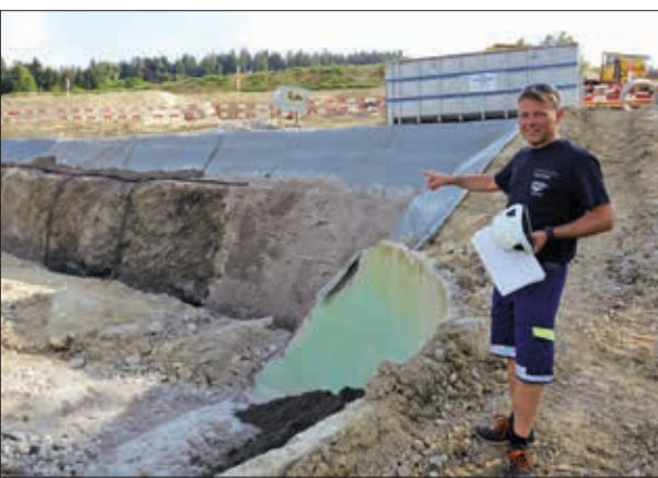
Thomas Oehri, Leiter der Wasserversorgung Teufen auf der riesigen Baugrube in der Schwendi. Foto: EG
