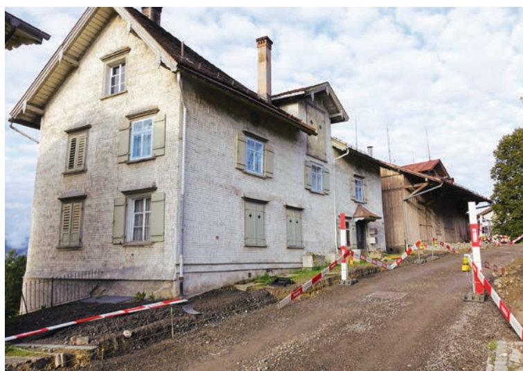
Die Liegenschaft an der Unterrainstrasse vor dem Abbruch.
