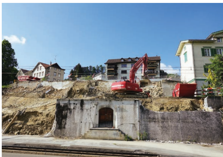
Neben dem Gewölbekeller entsteht die neue Tiefgarage.
