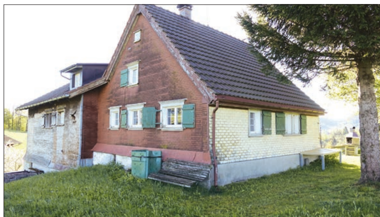
Das Wohnhaus soll abgebrochen und durch einen Neubau ersetzt werden. Foto: EG
