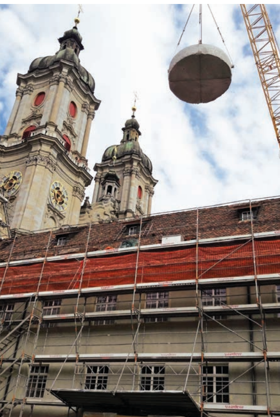
Der Brunnen ist aus einem Stück gefertigt und wiegt 21 Tonnen. Fotos: zVg.
