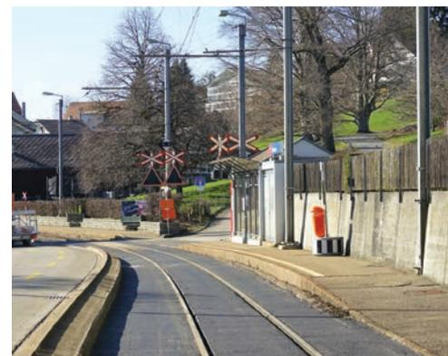
Im Stofel und beim Sternen wurden die Gleisanlagen asphaltiert und als provisorische Haltebuchten ausgebaut, so dass der motorisierte Verkehr während des Stopps passieren kann.
