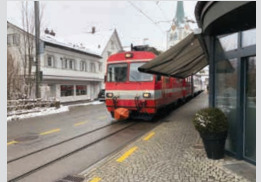
Verkehrsbehinderungen gibt es auch im Dorf. Der Verkehr wird während dem Einbau neuer Kabel für die Bahn mit Lichtsignalanlagen geregelt.
