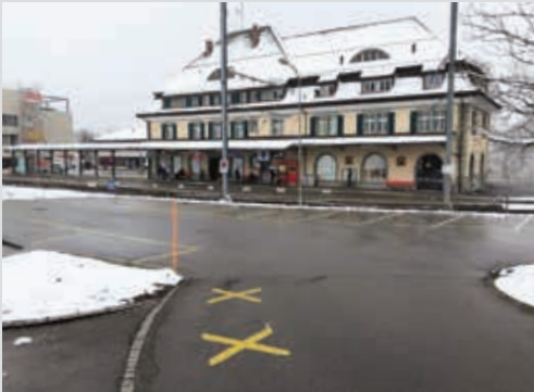
Der P&R-Parkplatz beim Bahnhof wird vorübergehend aufgehoben und dient während dem Bahnhofumbau als Bauinstallationsplatz.
