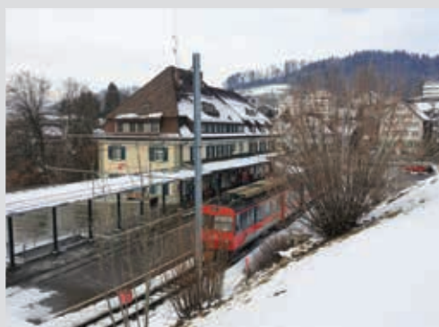
Beim Bahnhof werden ein 3. Gleis und neue Perronanlagen eingebaut.
