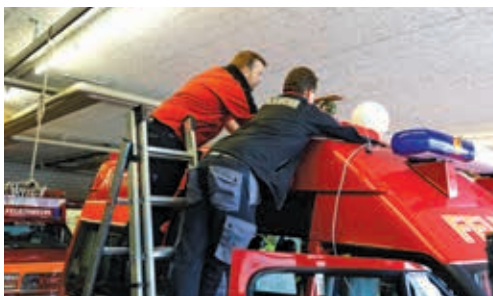
Die mobile Sirene wird auf dem Dach des Einsatzfahrzeugs montiert.
