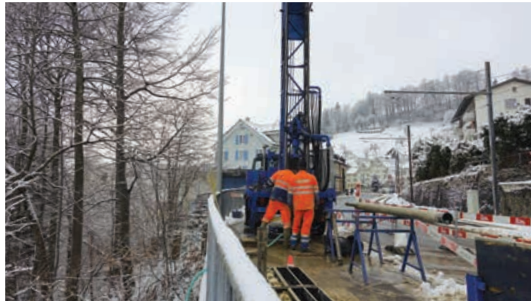
Der kleine mobile Bohrturm im Bereich Brauerei.
