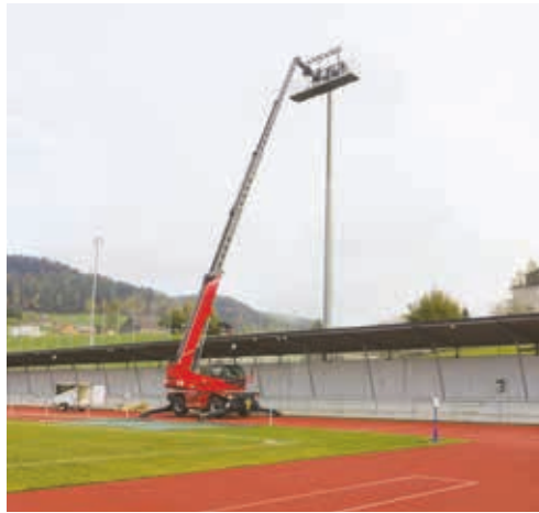
Zum Einsatz kam auch die Hebebühne von Züst Bedachungen.
