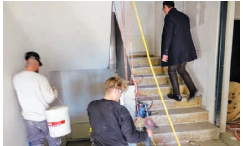
Mit Hochdruck an der Arbeit: Bis Ende Jahr soll der Umbau abgeschlossen sein.
