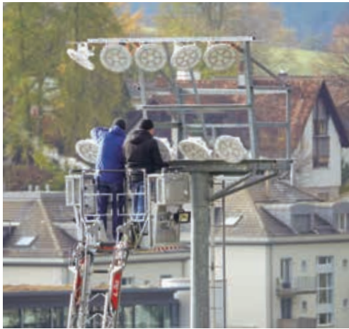
Arbeit auf luftiger Höhe: Spezialisten justieren die Ausrichtung jedes einzelnen Scheinwerfers aufgrund elektronisch ermittelter Werte.
