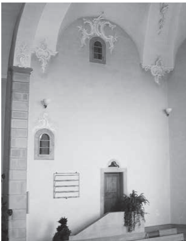
Hans Ulrich Grubenmann erneuerte die Kirche von Teufen 1776–1779 in Etappen. Einzig die Mauer zwischen Chor und Turm blieb vom vorreformatorischen gotischen Gotteshaus bestehen. Foto: EP
