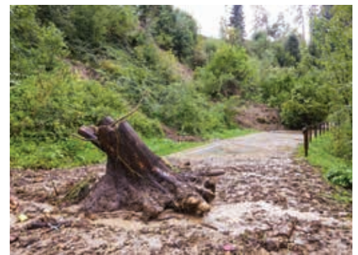
Gleich zwei Erdrutsche gingen an der Alten Speicherstrasse, im sogenannten Pfifetöbeli nieder und verschütteten die Strasse.
