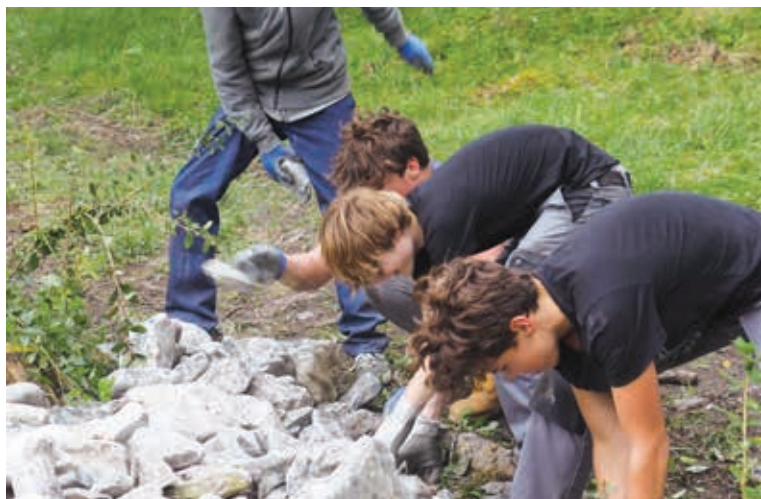
Die Klasse 3b baut an der Trockenmauer in Trimmis.
