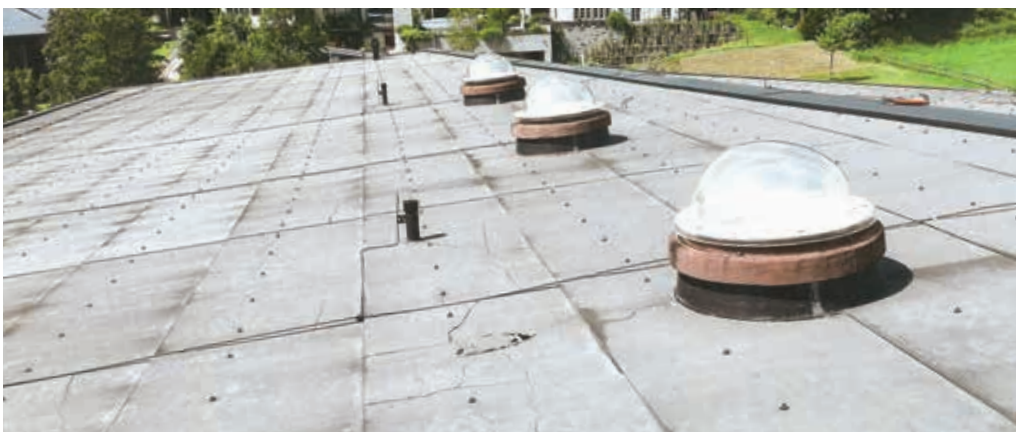
Undicht: Nach 13 Jahren muss die Dacheindeckung des Schulhauses Landhaus ersetzt werden. Foto: zVg.
