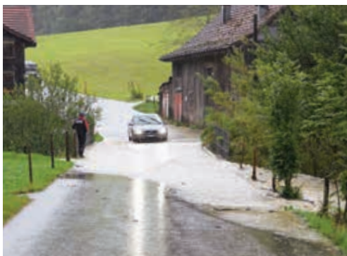
Die Brücke über den Goldibach konnte das viele Wasser nicht mehr schlucken.
