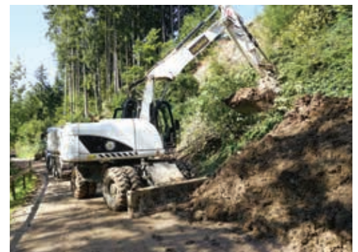
Die Aufräumarbeiten an der Alten Speicherstrasse sind in vollem Gang.
