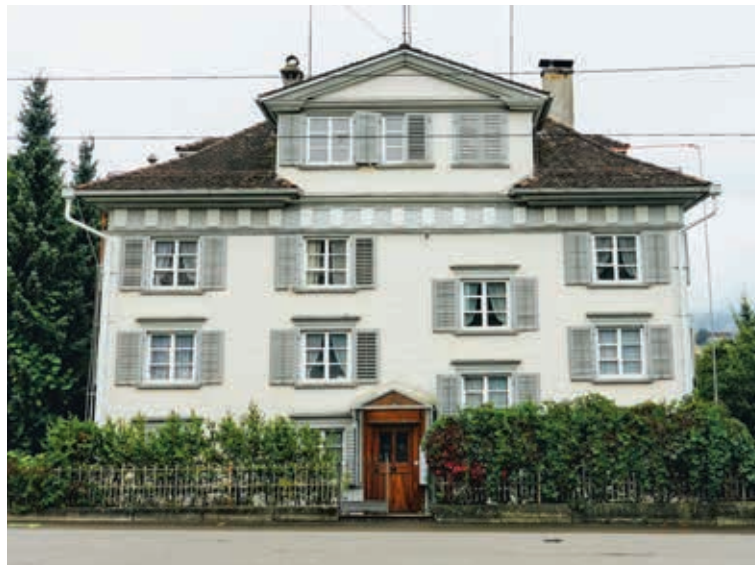
Das Haus Dorf 18 soll angehoben und leicht verschoben werden, damit ein Trottoir Platz hat. Foto: EG
