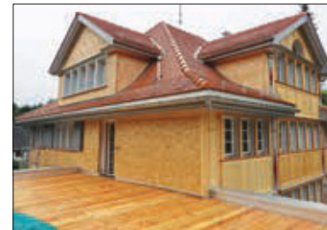
Rechts: Die Terrasse über dem Anbau wurde mit wetterfester Douglasie gedeckt.
