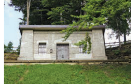
Das Reservoir im Schlipf aus dem Jahre 1912 hat seinen Zweck erfüllt und soll abgebrochen werden.
