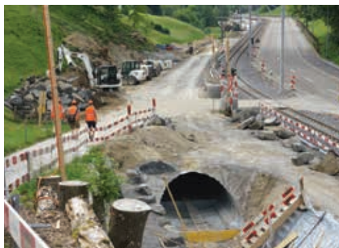
Blick auf die Unterquerung des Feldwaldbaches bei der Einmündung der Hofzufahrt. Der Bahnübergang wird künftig mit Schranken gesichert.
