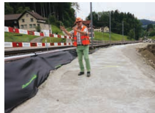
Oben beim Sonnenrank: Richard Signer zeigt, wo die Doppelspur endet und die neue Weiche eingebaut wird. Rechts der verlegte, offene Feldwaldbach.
