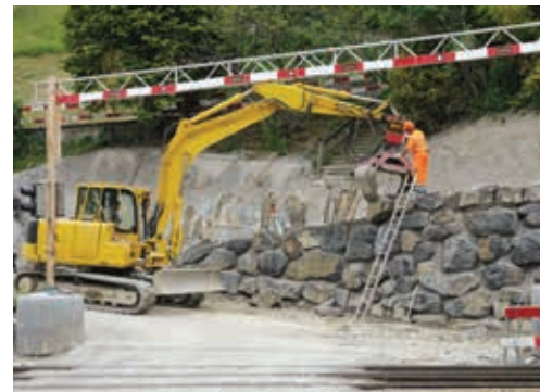
Der Bau der ersten Stützmauer. Der Hang dahinter wurde mit Spritzbeton und Nägeln verankert. Die Felsbrocken aus Alpenkalk sind eine halbe bis zu einer Tonne schwer.
