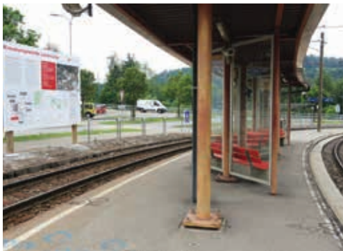
Der Umbau der Bahnstation Lustmühle wird erst bei der Total Einstellung des Bahnbetriebs im nächsten Frühjahr in Angriff genommen.
