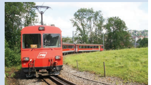
Die engste Zahnradbahnkurve Europas: Die Ruckhalde wäre für den Langsamverkehr besser geeignet, findet die Stadt. Archivaufnahme: EG
