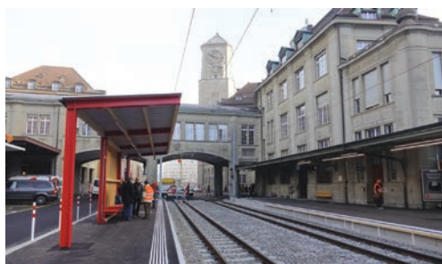
Das neue Gleis 11
