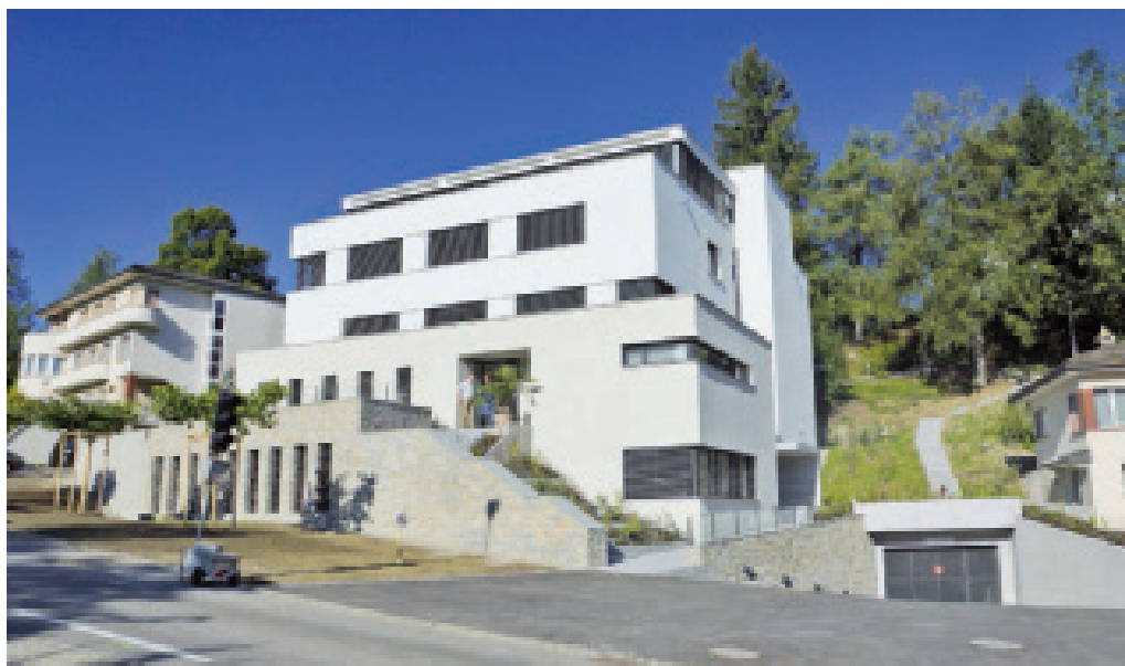
Das neue Therapiehaus erweitert die Kapazitäten der Paracelsus Klinik um rund 30 Prozent. Fotos: EG
