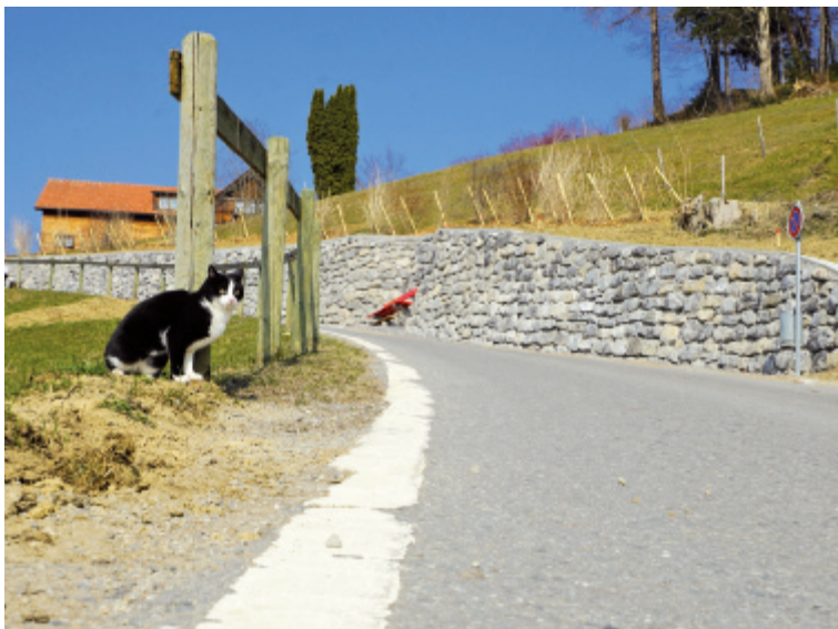
Die Hangsicherung der Bündtstrasse mit Ruhebänk lädt zum Verweilen ein. Foto: EG
