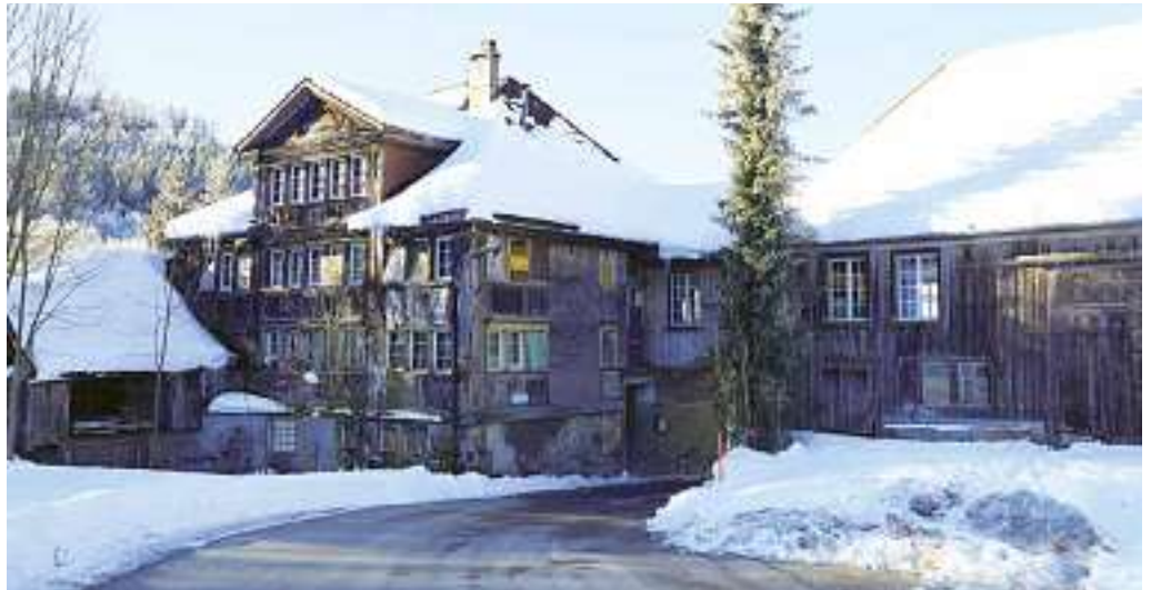
Das ehemalige Restaurant mit Mühle macht einen vergammelten Eindruck. Fotos: Erich Gmünder
