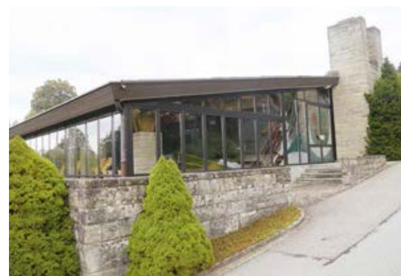
Strom vom Dach der Abdankungshalle – der Gemeinderat hat einen Kredit gesprochen. Foto: Erich Gmünder
