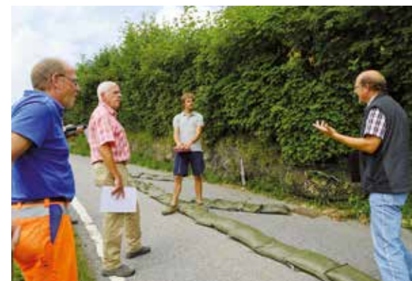
V.l.n.r.: Bauamtsleiter Kurt Keller, Gemeindepräsident Walter Grob, der Geologe Jürg Rusch und Gemeindeingenieur Ueli Anderfuhren bei einer Lagebesprechung am Rutschhang. Foto: EG
