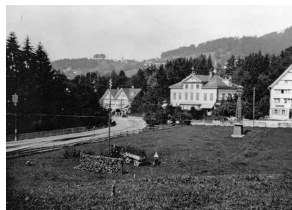
Das heutige Bahnhofareal kurz vor Baubeginn.
