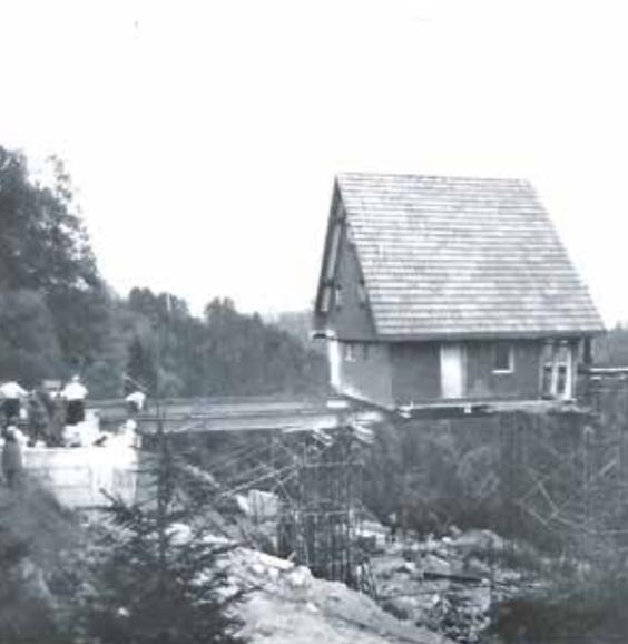
Das rund 60 Tonnen schwere Haus wurde mit Hydraulikpressen achteinhalb Meter hochgehoben und dann auf das Fundament verschoben.
