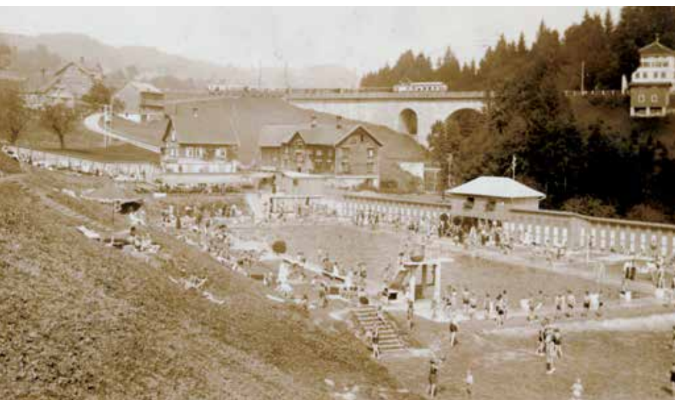
Das Schwimmbad nach der Eröffnung, 1933.
