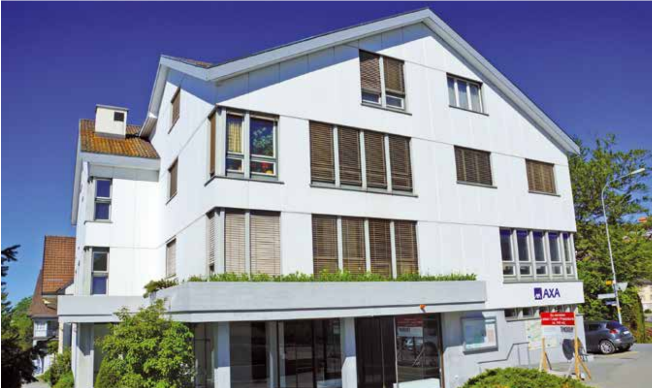
Das Geschäftshaus Dorf 5, wo sich vorher der Spar befand, wechselte die Hand. Es gehört neu der Immobilien Posthof AG in Amriswil. Foto: EG
