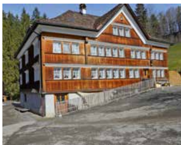
Die Obere Lochmühle, mit Unterstützung des Heimatschutzes 1988 – 90 restauriert.
