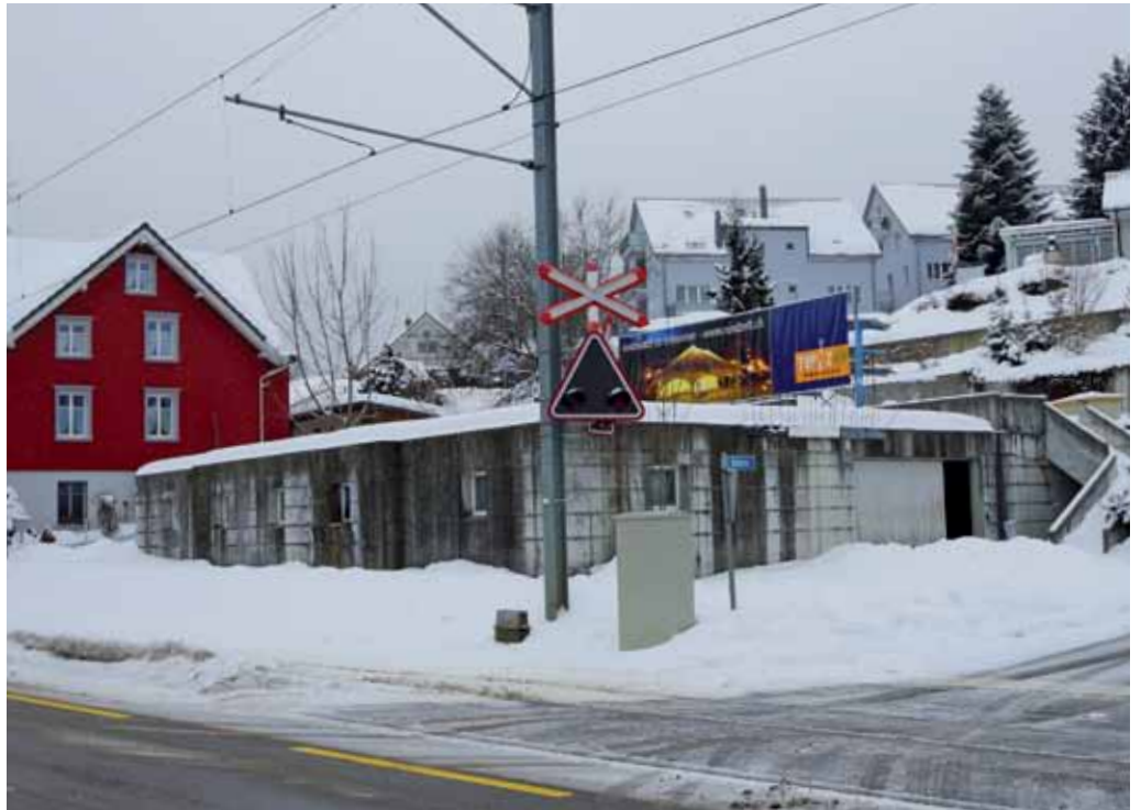
20 Jahre lang ein Ärgernis: Die Bauruine bei der Einmündung Blattenstrasse. Foto: EG
