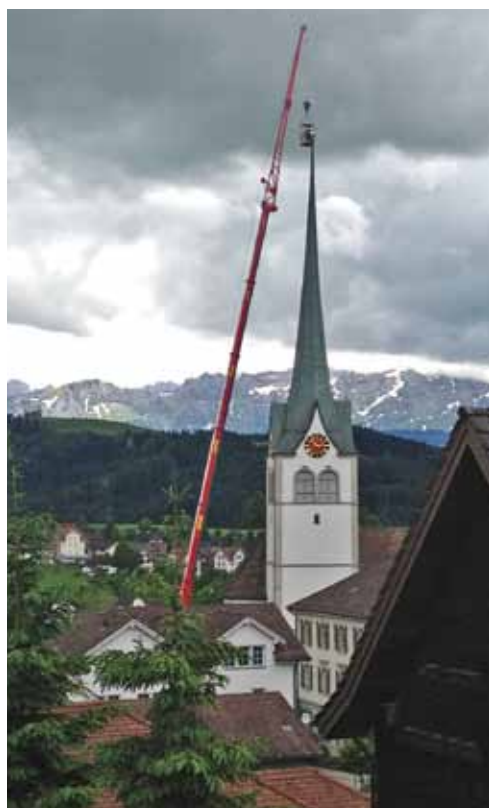
Der Kran mit einem Ausleger von 68 Metern Länge reicht gerade knapp für den 65 Meter hohen Turm der Grubenmannkirche. Leserbild: Odilia Hiller
