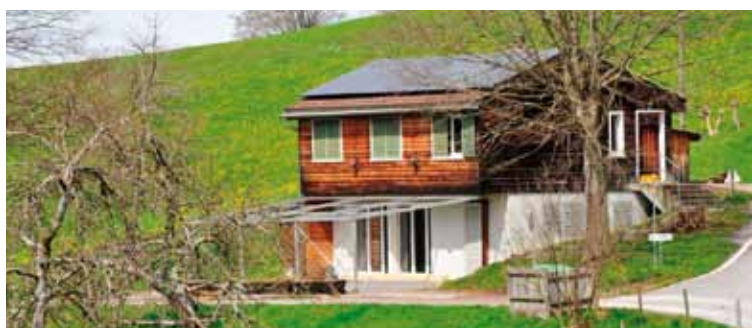
Das Pfadiheim mit dem neuem Solardach.
