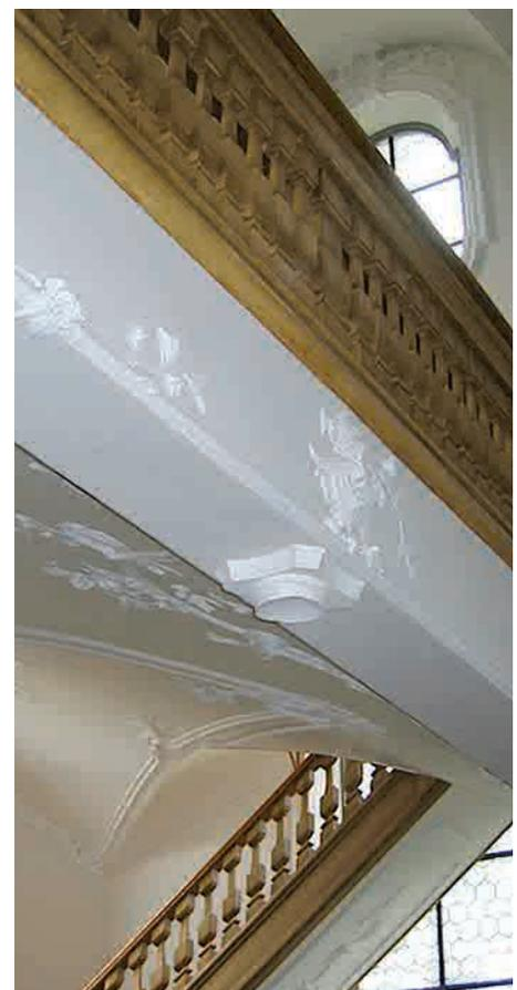
Mit diesem zusätzlichen Kapitell aus Stuck verwies Grubenmann darauf, dass andere Kirchenbauer an diesem Ort eine Stütze hätten einsetzen müssen.
