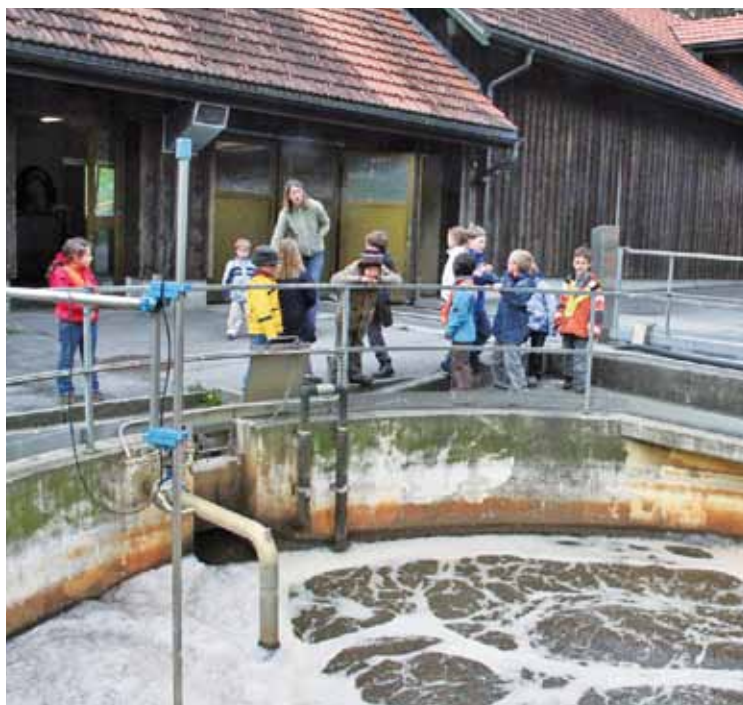
«Kleine Viecher fressen unseren Dreck»: Die Schüler lassen sich in die Geheimnisse der Kläranlage einführen. Fotos: AG
