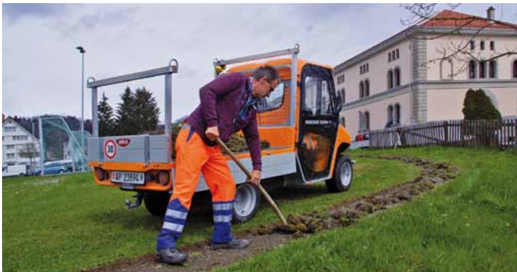
Rechtzeitig vor der Eröffnung wurde der alte Spazierweg ab Sammelbüel wieder instandgestellt. Foto: EG
