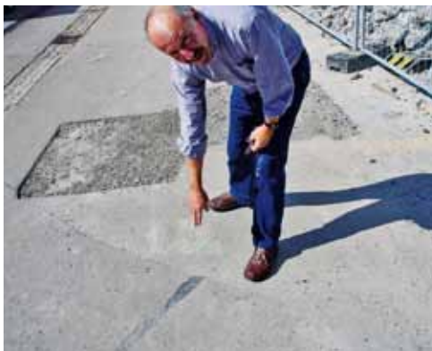
Die Stelle, wo der Zug ausbüxte und über das Trottoir in sein Geschäft fuhr, war bis vor kurzem noch im Asphalt zu sehen.
