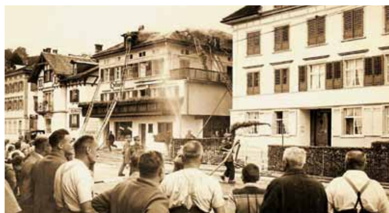
1. Oktober 1958, der Ochsen brennt. Im Dachstock werden Hotelzimmer eingebaut.
