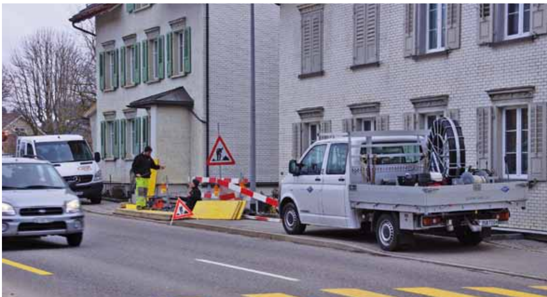
Bereit zum Verlegen: Die Kunststoffrohre kommen auf riesengrossen «Fadenspulen» daher. Foto: EG
