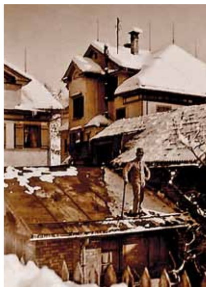
Noch vor seiner Heirat begann Ernst Sutter eigenhändig mit dem Abbruch der alten Metzgereiräumlichkeiten. Ein schwieriger Start für die junge Ehefrau, zeitweise war der Zugang zum Schlafzimmer nur über eine Leiter möglich.
