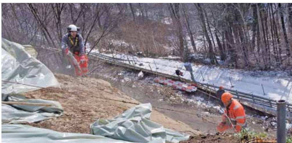
Mit Seilen gesichert: Anspruchsvolle Arbeit am Felsen hoch über der Umfahrungsstrasse (im Hintergrund der Radarkasten).
