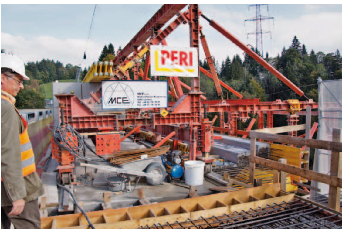
Mit diesem Gerät auf Schienen wird die neue Fahrbahnhälften betoniert.
