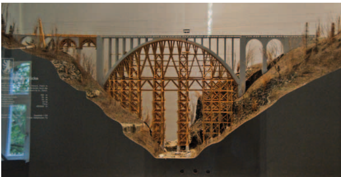
Dieses Modell der Gmündertobelbrücke steht im Tiefbauamt AR und zeigt das ursprüngliche Projekt mit Lehrgerüst und Seilkran aus dem Jahre 1907/08. Fotos: EG
