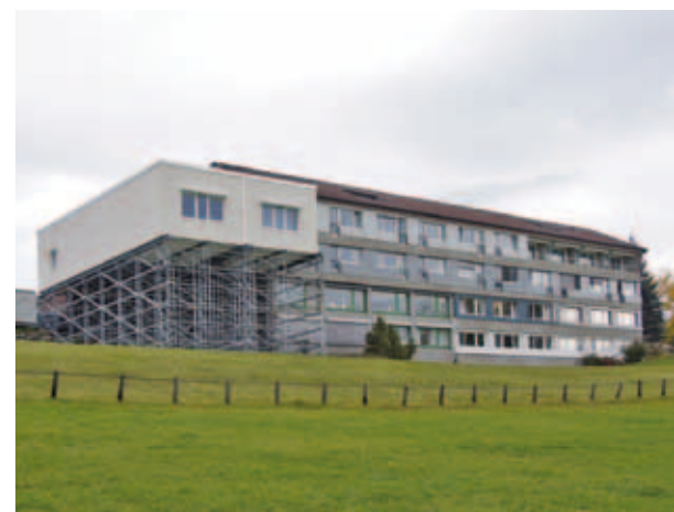
Provisorium auf luftiger Höhe. Foto: EG
