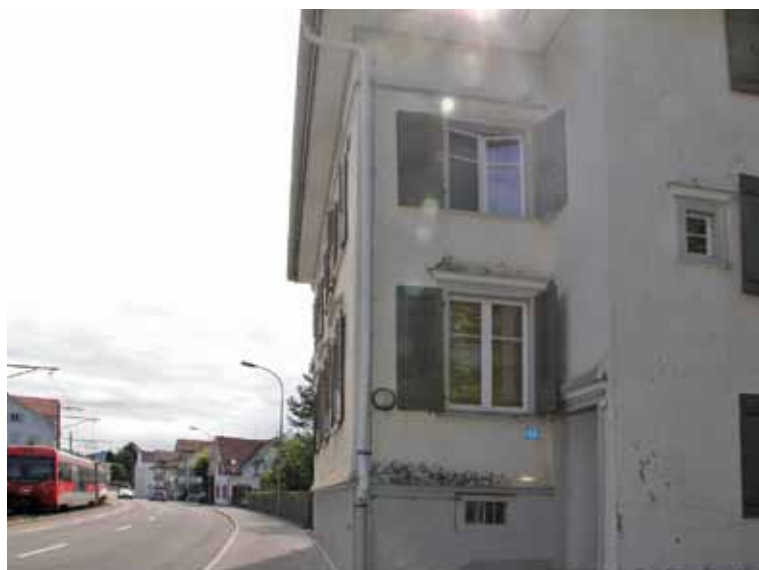
Bis Ende 2011 dient das ehemalige Schulhaus Blatten als Asylunterkunft. Fotos: AG
