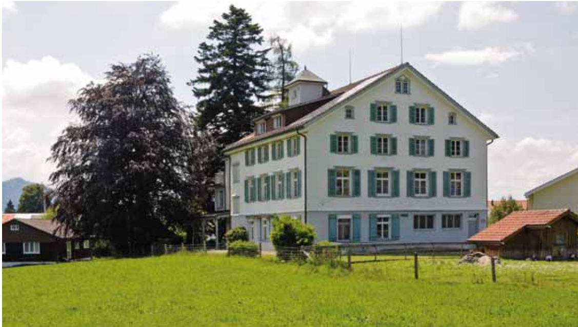
Das ehemalige Altersheim Alpstein wurde 2010 zur Gruppenunterkunft umgebaut. Fotos: AG
