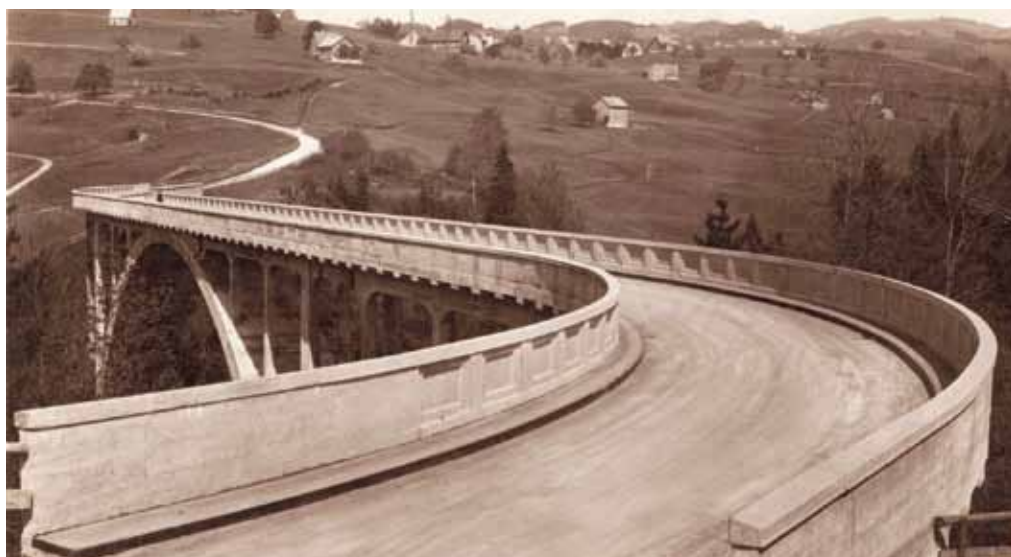
Sie war der Auslöser: Die sanierungsbedürftige S-förmige Rotbachbrücke zwischen Haslen und Teufen wurde 1984 abgebrochen, nachdem gleich daneben die heutige Brücke erstellt worden war. Aus der Sammlung von Werner Holderegger, um 1924
