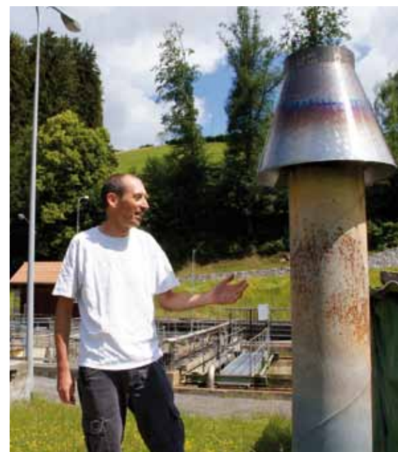
ARA-Betriebsleiter Michael Stern zeigt die Fackel, wo das bisher nicht verwertbare Biogas verbrannt wird. Fotos: EG
