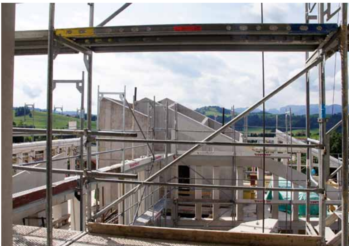
Das 9-Mio-Projekt ist im Rohbau erstellt. Fotos: EG
