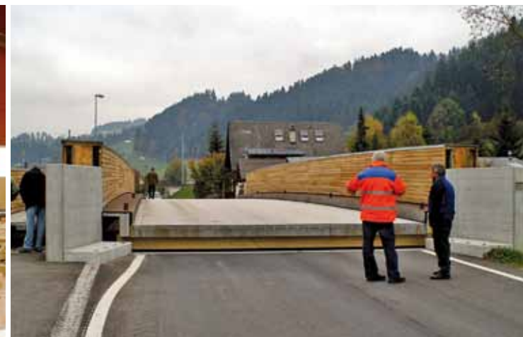
Die erste, bei Hochwasser hydraulisch hebbare Strassenbrücke in Holz Obermattbrücke bei Langnau im Emmental 2007.
