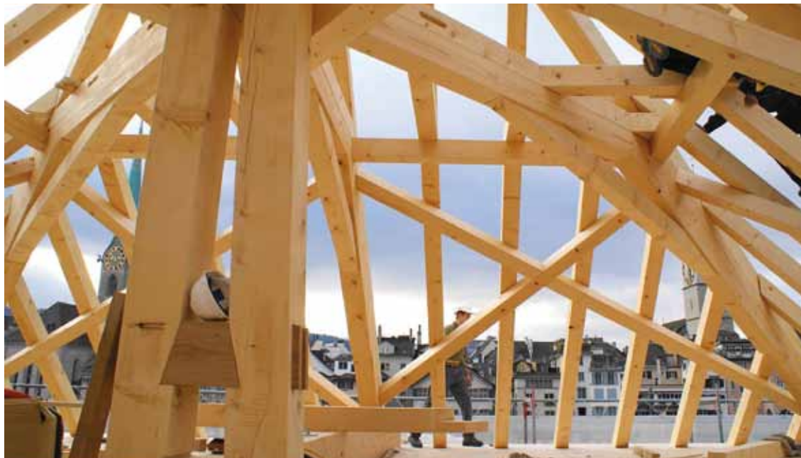
Zunftthaus zur Zimmerleuten, Wiederaufbau nach Brand (2007).
