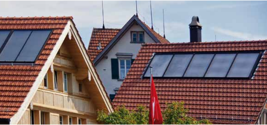
Tradition und Moderne vertragen sich: Sonnenkollektoren auf Giebeldächern beim Schönenbüel.
