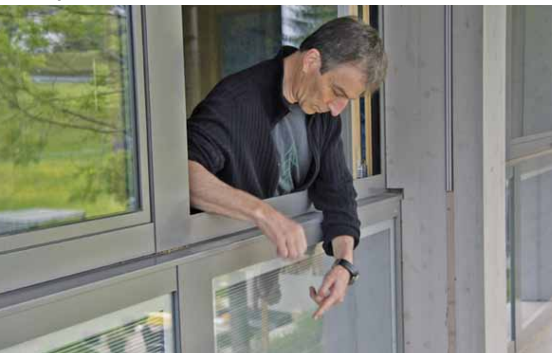
Eugen Bartholdi zeigt eine besonders intelligente Form, Sonnenergie zu nutzen: Unterhalb der Fenster sind Paneele mit Salzkristallen eingebaut, die im Winter die Wärme einfangen und an den Innenraum abgeben, wie ein Kachelofen.
