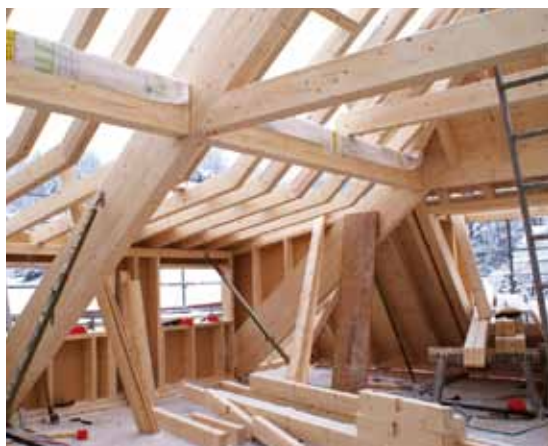
Neuer Dachstuhl Haus «Eben Ezer» Teufen.
