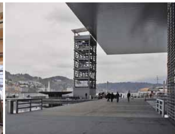
Dachkorrektur KKL Luzern: Gerüstturm.
