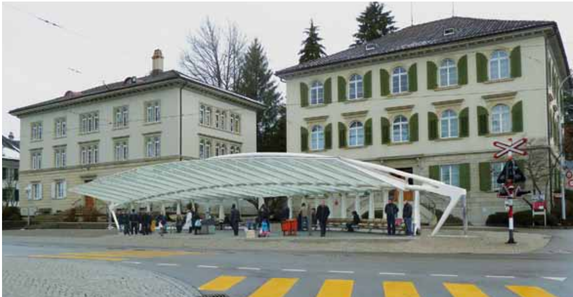
Jetzt ist es definitiv: Das futuristische Bauwerk des berühmten Stararchitekten wird im Grubemann-Dorf aufgestellt. Foto: US
