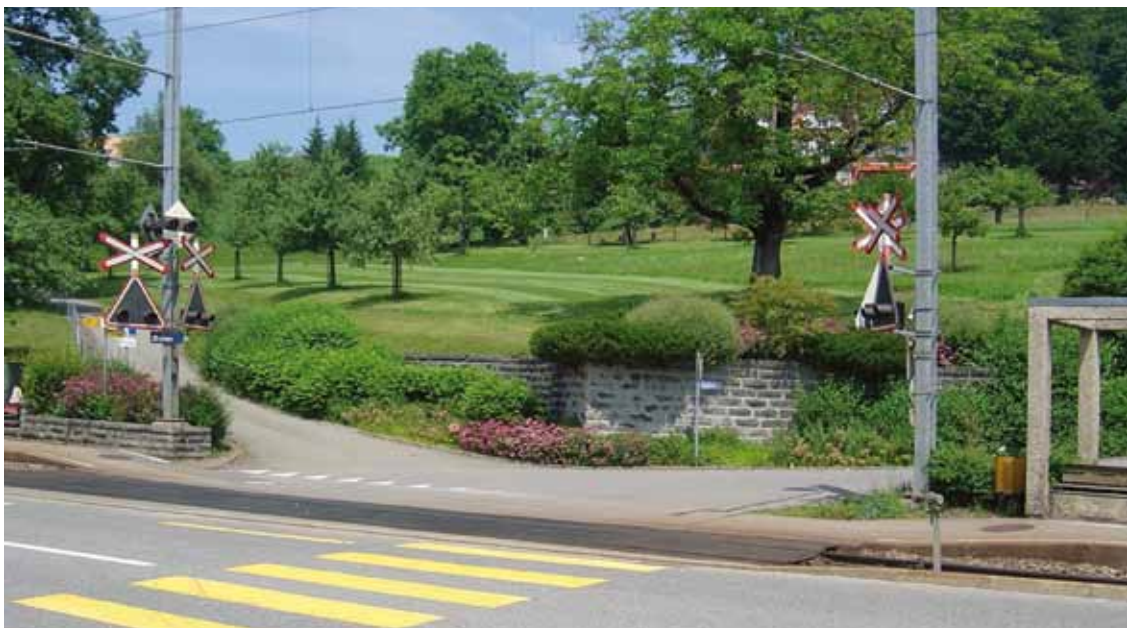
Der sanierungsbedürftige Bahnübergang bei der Haltestelle Sternen. Foto: zVg.
