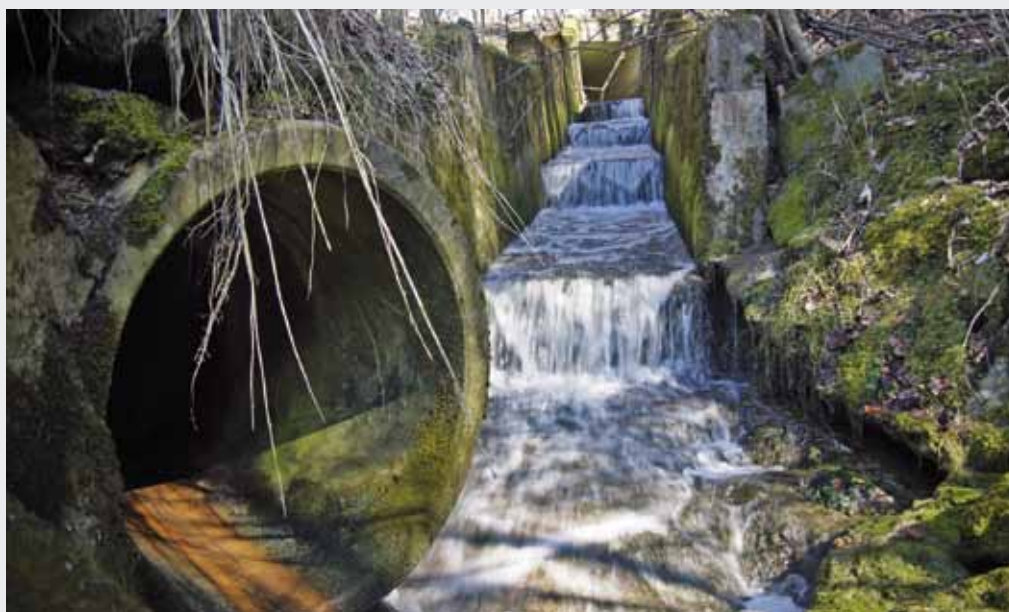
Bei der Sanierung 1995 wurde das Bächli neu gefasst. Die grosse Röhre links dient zur Entwässerung der Deponie
