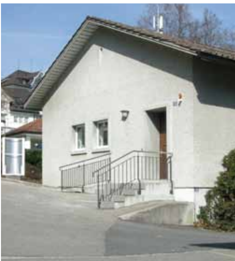
Die alte Telefonzentrale wird umgebaut. Foto: HS
