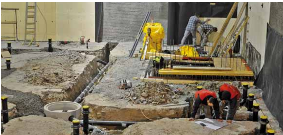
Die Renovationsarbeiten im Zeughaus kommen planmässig voran. Foto: Paul Hugentobler
